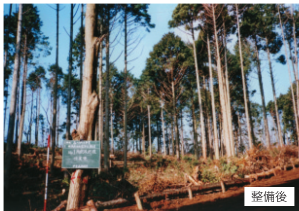
▲風倒木を処理し、簡易木製構造物を施工
