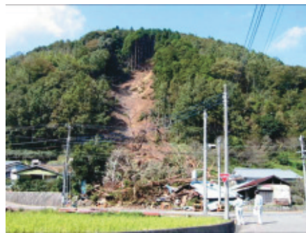
▲写真-1 緊急治山事業施行地 伊豆市上船原 被災時
