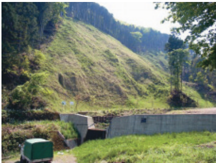
▲写真-6 同上現況(H19.4) 谷止工(緊急)、山腹工(H17復旧)
