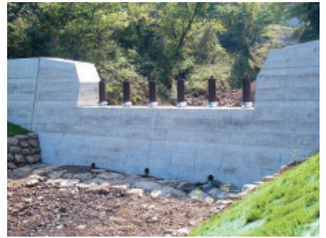
▲写真-8 H18復旧治山事業施行地 伊東市宇佐美 現況(H19.4) 谷止工に簡易流木止(スリット)を設置し、 現地発生転石を利用した河床整理を行った。
