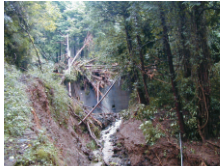
▲山地災害危険地区内の治山ダムが流木を補足し、下流の被害を最小限に抑えた事例
