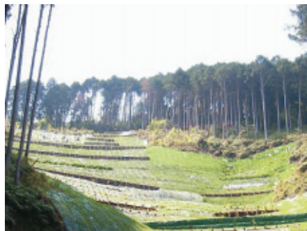
▲写真-7 H18地域防災治山事業施行地 沼津市内浦重須 現況(H19.4) 現地発生木材を利用した山腹工
