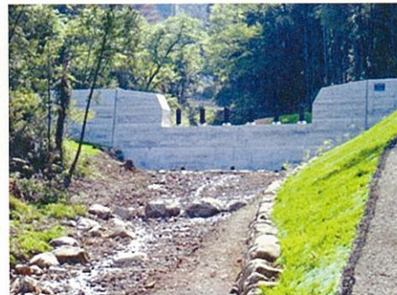
▲受賞工事完成写真
