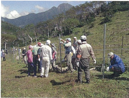
▲ボランティアによる防鹿柵の設置作業(三伏峠)
