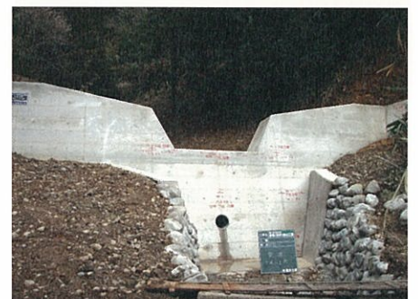
▲H18年度 市施工 谷止工 (葵区新聞)
