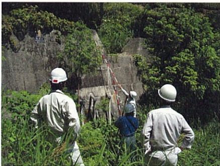
▲治山パトロールの状況
