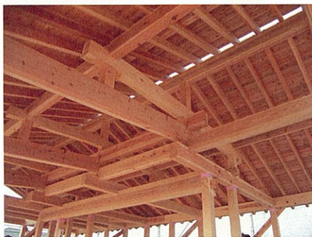
▲「しずおか優良木材」を利用した住宅建築の様子
