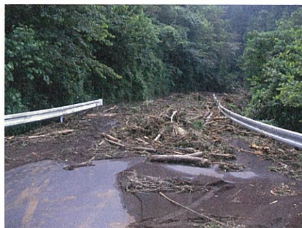
▲広域基幹林道：崩落土砂、流木が路面に推積
