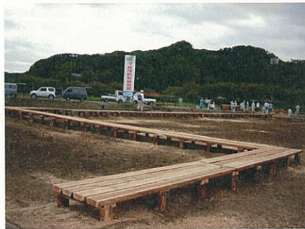
▲完成した木道
