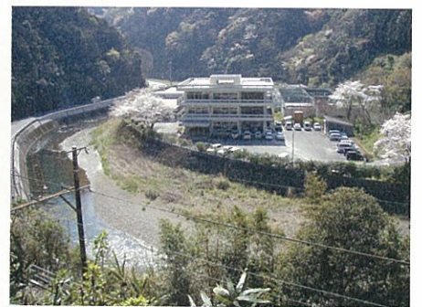
▲下田市落合浄水場
