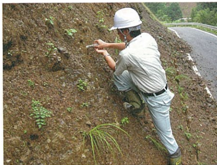
▲法面の現地調査の様子
