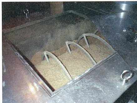
▲バイオ式（オガクズ）トイレ (オガクズを利用して微生物の活動を活性化させ、し尿を分解)
