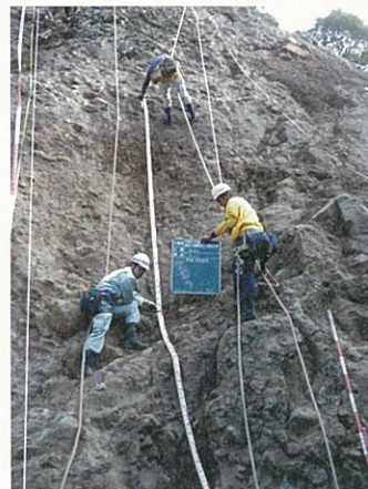
▲山腹法面の出来型確認の様子
