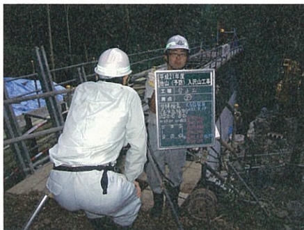
▲谷止工の型枠検査の様子(筆者:写真正面)
