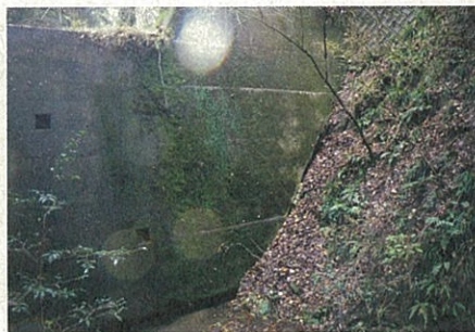
▲写真2 左岸袖部の状況
