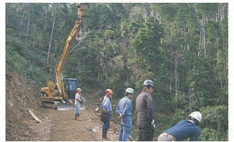
▲スイングヤードによる集材実技研修（浜松市三ヶ日町）
