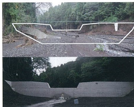
▲転倒した谷止工を復旧しました
