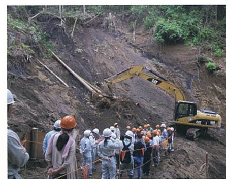
▲災害復旧現場で見学会
