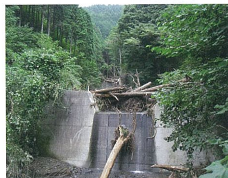
▲治山ダムの減災効果（流木の捕捉の様子）
