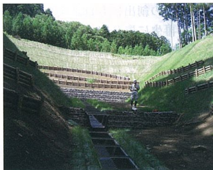
▲人家裏の山腹工（小山町湯船）
