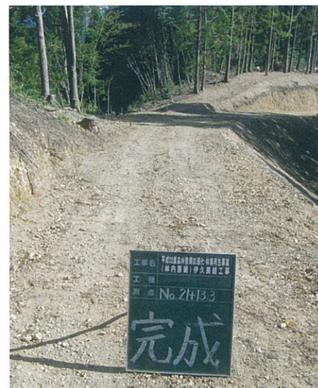
▲林業専用道 伊久美線（島田市）
