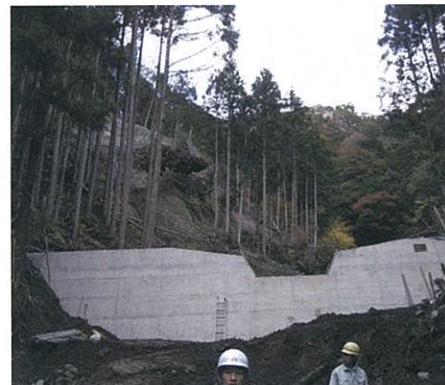
▲小山町柳島H23谷止工施工状況
