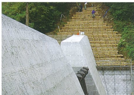
▲内浦重須 砂防堰堤の間詰工（沼津市）
