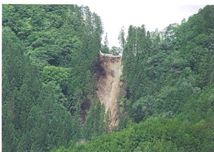
▲林道 池の平矢岳線災害現場
