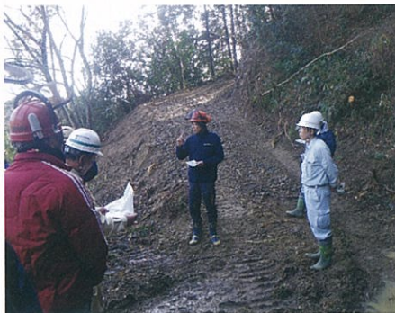
▲作業道研修(掛川市内)
