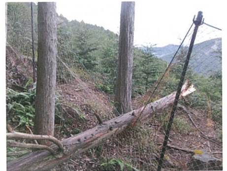
▲倒木による防護柵の被害
