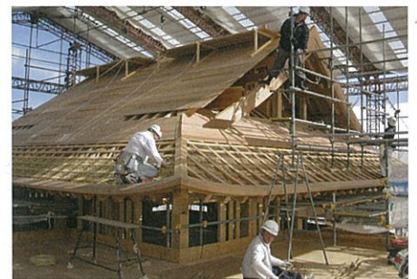
▲組立ての様子（県木連提供）
