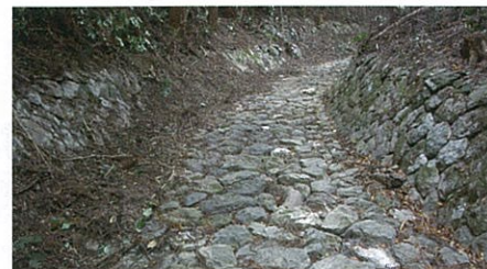
▲雑割石空積みの流路工
