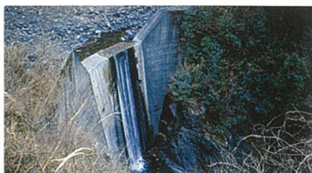
▲アーチダム施工時（昭和44年）
