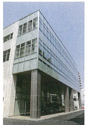
▲完成した新庁舎
