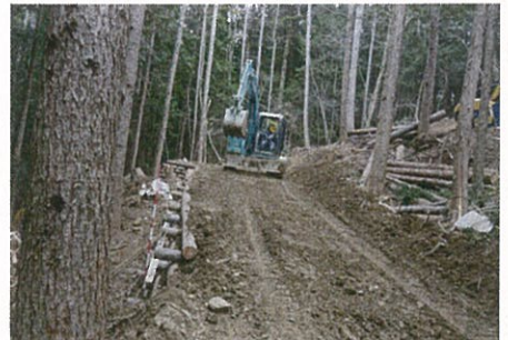
▲森林作業道「谷ノ沢日向・ヲヲダア線」の施工状況
