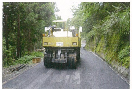
▲林道竹ノ沢線の舗装の施工状況
