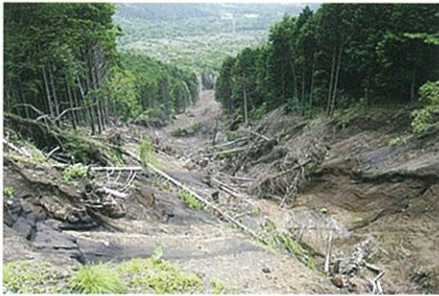
▲北郷地域（角取山地区）被災状況
