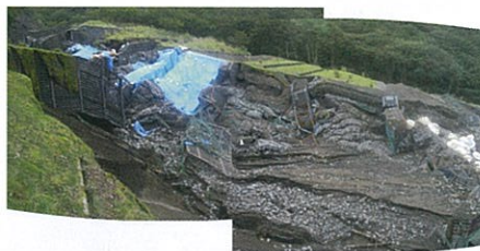
▲既設治山施設の被災状況
