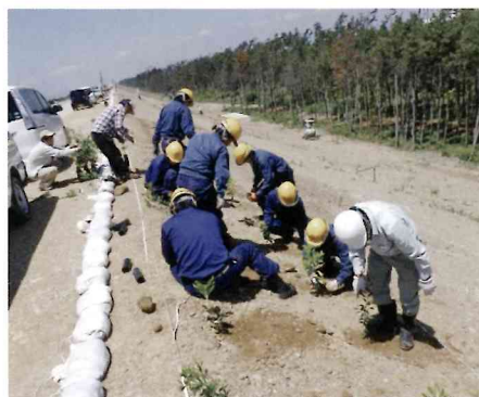
▲写真-2 浜松市沿岸域防潮堤植栽実習 (浜松市南区倉松町、平成28年5月)
