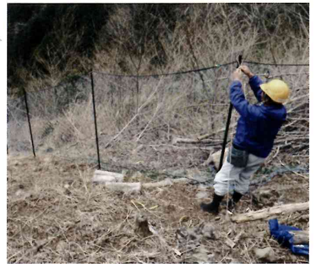
▲防護柵設置の様子
