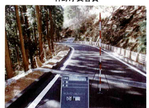
花菱建設 株式会社 No.13 堀坂線
