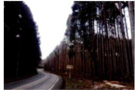
▲緊急間伐 完成
