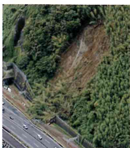
図-1 斜面崩壊状況(出典:www.at-s.com)
