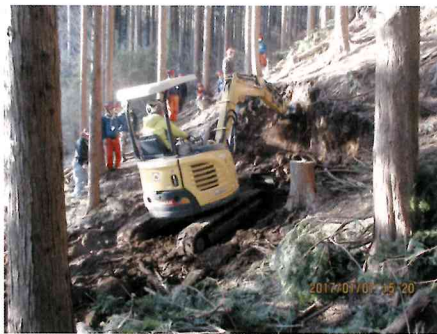
▲ 森林作業道開設研修
