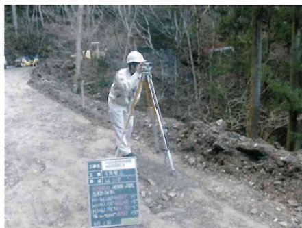
▲ 不陸整正工の基準高確認
