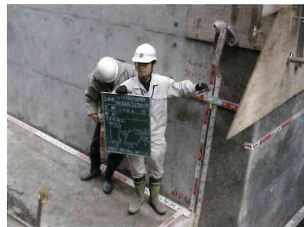
▲ 盛土擁壁の確認
