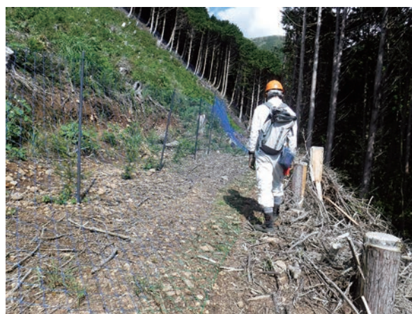
▲獣害防止柵の点検
