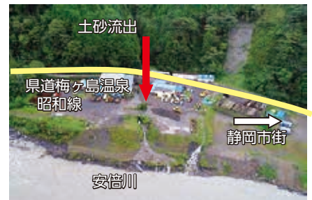
▲写真-2 令和元年台風19号による災害の状況
