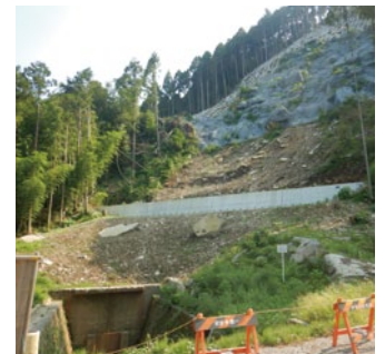
▲隧道入口付近山林法面復旧状況
