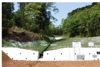
土屋建設(株) 伊豆の国市浮橋
