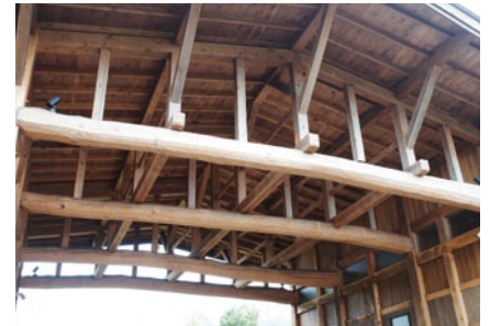
▲自社材を使用したトイレ(手刻みの梁等)
