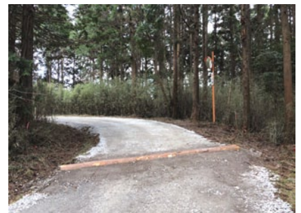
▲補修後の林道
