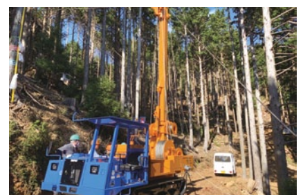
▲タワーヤーダ設置
