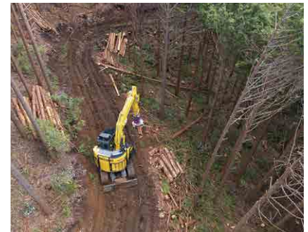
▲現場 施工状況
