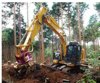
▲現場 施工状況
