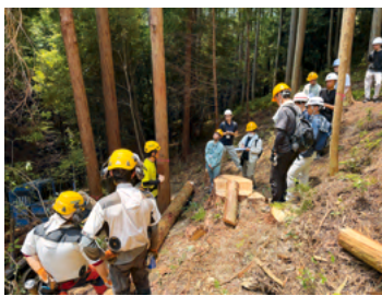
▲森林整備現場(天竜フォレスタース施工地)
